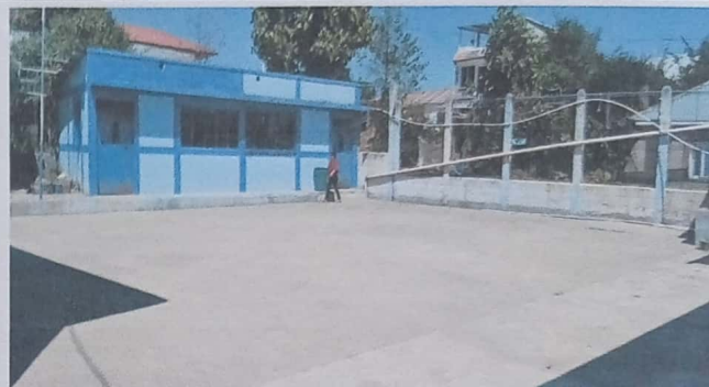
Foto 2: Estructura de Techo
